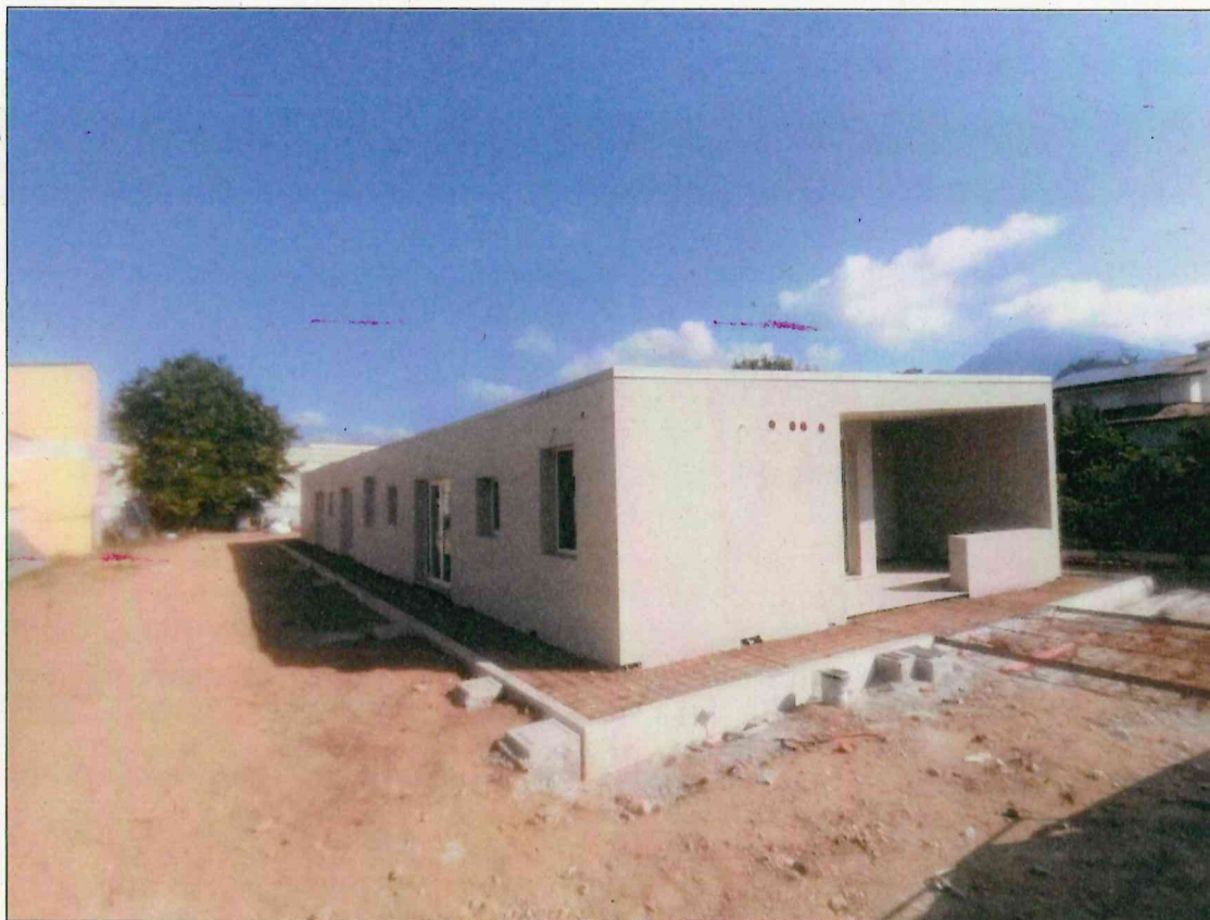
Foto realizzate in corso di costruzione del fabbricato
