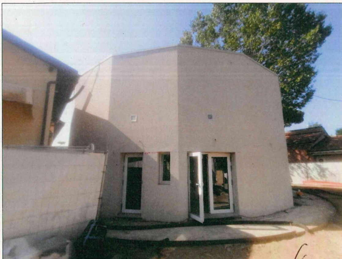
Foto realizzate in corso di costruzione del fabbricato
